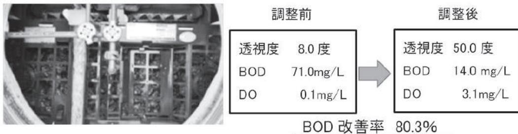
図-2 各移送水量の再調整における二次処理反応槽DOと処理水の結果
