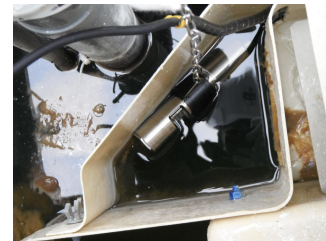
写真3 濁度計設置(処理水槽)
